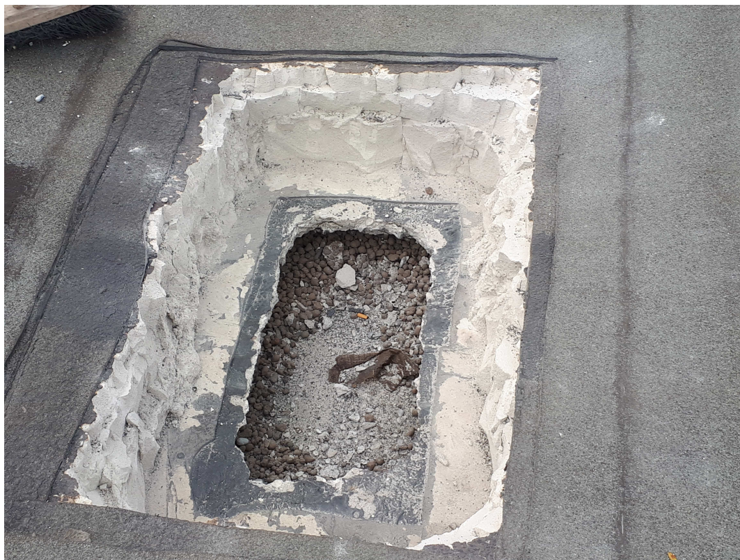
Vista stratigrafia solaio di copertura
